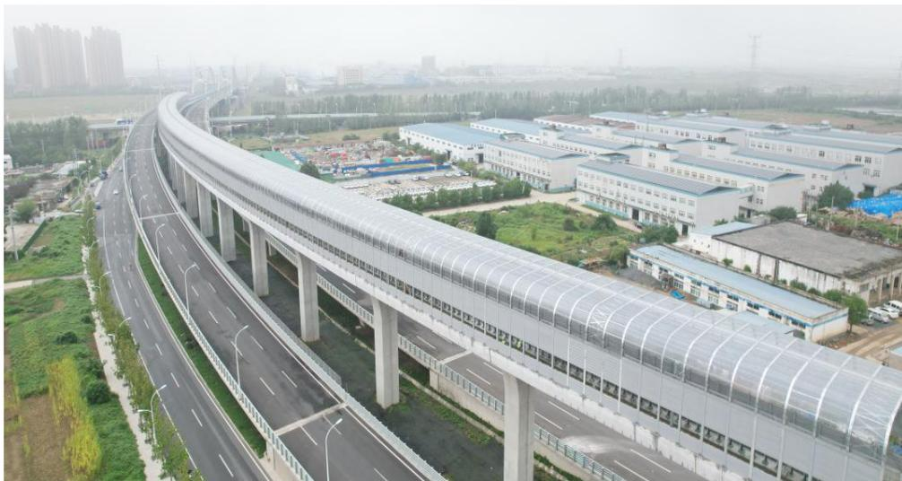
图 5-4 安徽省合肥市城市轨道交通声屏障
